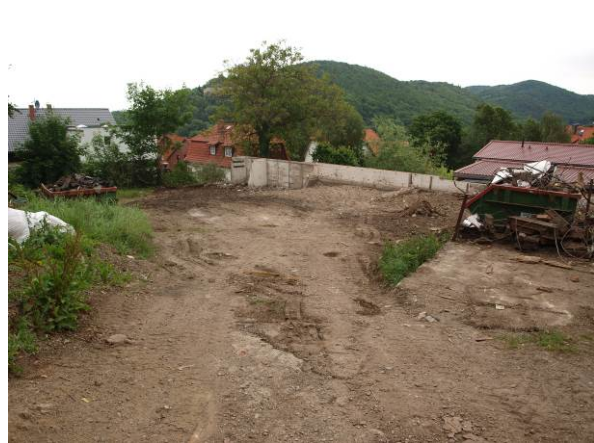
Ehemalige Zufahrt mit Parkplatz im Südosten (Blick Richtung Südosten)
