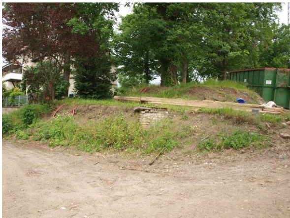
Kellerreste des alten Hotels im Bestand bis Juni 2017
