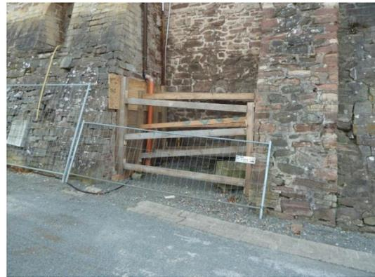
vor der Sanierung, große Teile der Mauer sind ausgebrochen, Sicherungen mit seitlichen Abstützungen und Bauzäunen
